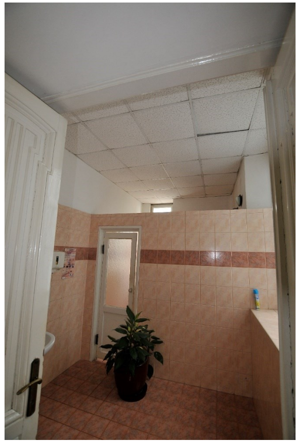
Slika 16. Pogled na prostoriju broj 26 koja se nalazi na prvom katu zgrade
