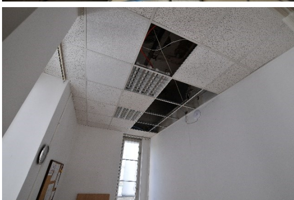
Slike 8. i 9. Pogled na izvorni i spuštenu Armstrong strop prostorije broj 16b koja se nalazi na prvom katu zgrade
