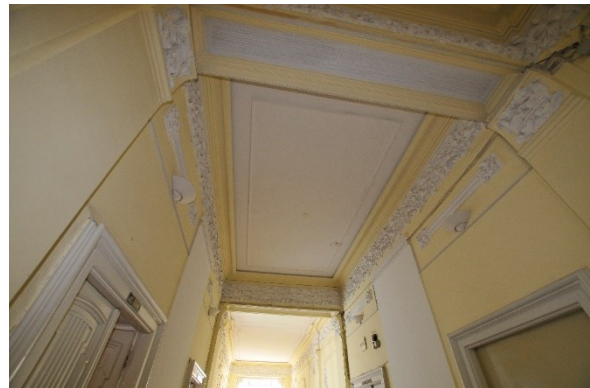
Slika 18. Pogled na strop hodnika koji se nalazi na prvom katu zgrade
