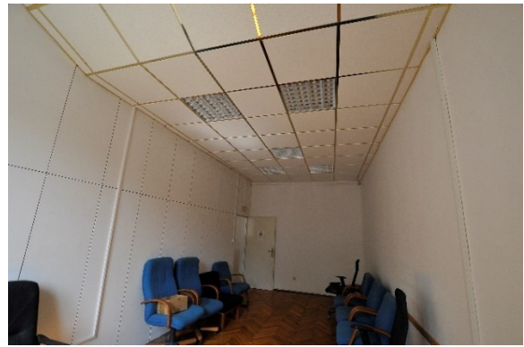
Slika 12. Pogled na prostoriju broj 19 koja se nalazi na prvom katu zgrade
