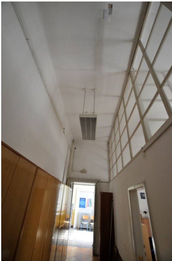
Slika 15. Pogled na prostoriju broj 24 koja se nalazi na prvom katu zgrade
