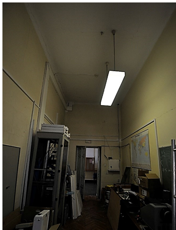
Slika 2. Pogled na prostoriju broj 6 koja se nalazi u prizemlju zgrade
