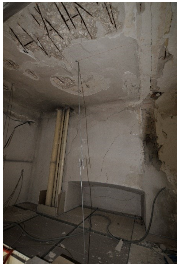
Slika 10. Pogled na izvorni i spuštenu Armstrong strop prostorije broj 16b koja se nalazi na prvom katu zgrade
