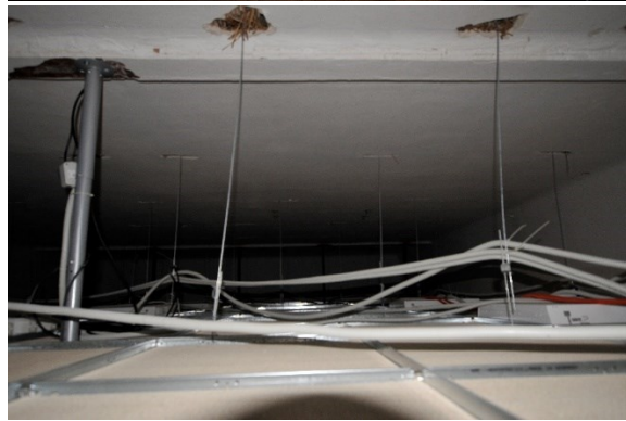
Slike 6. i 7. Pogled na izvorni i spuštenu Armstrong strop prostorije broj 11 koja se nalazi u prizemlju zgrade
